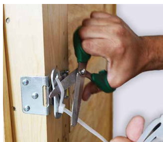
图 8. 去除锁销上的一条扎带。
