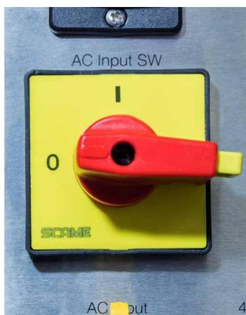
Abbildung 3.5. Hauptnetzschalter in Stellung „Aus“ abgebildet.
