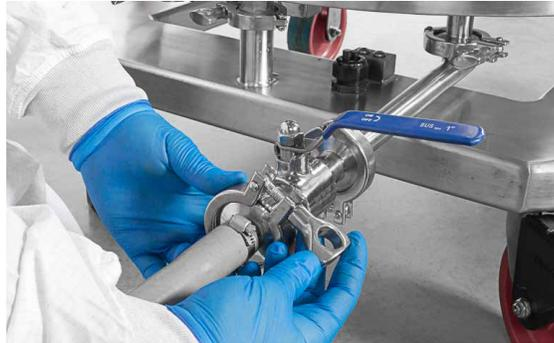
**Abbildung 2.11. Verbinden der TCU mit dem Wassermantel.**
