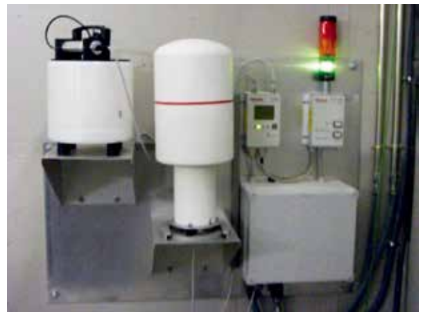
FHT 6020区域监测系统实景图
