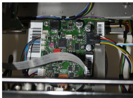
图 141. P-Bus 通信线缆
