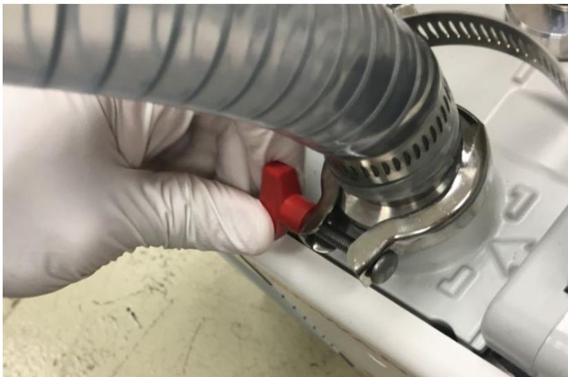
图 21：安装排气软管的夹钳
