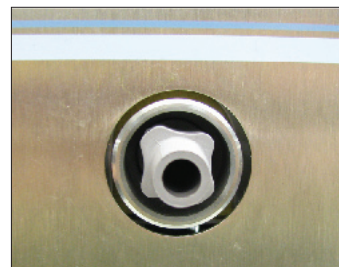
Installierte Abflussarmatur mit abgenommener Kappe
