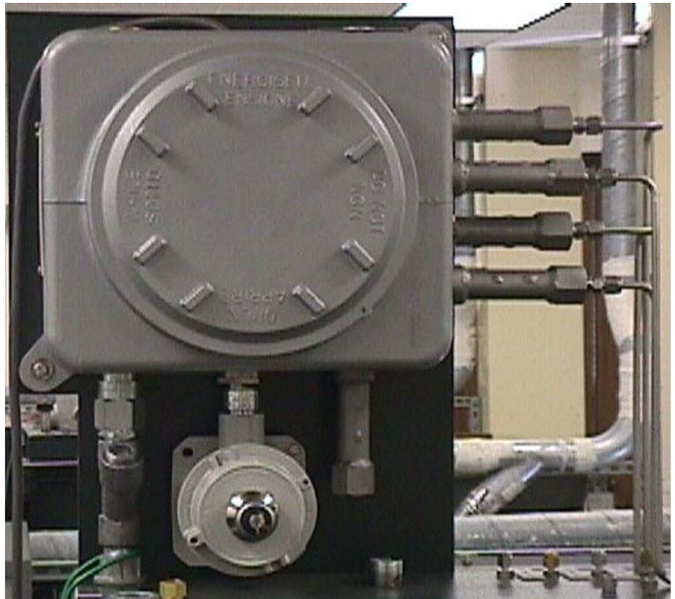
Figure G-1. Unité de commande de la purge (version ATEX sur la photographie. Sur la version NFPA, l'interrupteur à clé est situé à l'intérieur du boîtier.)
